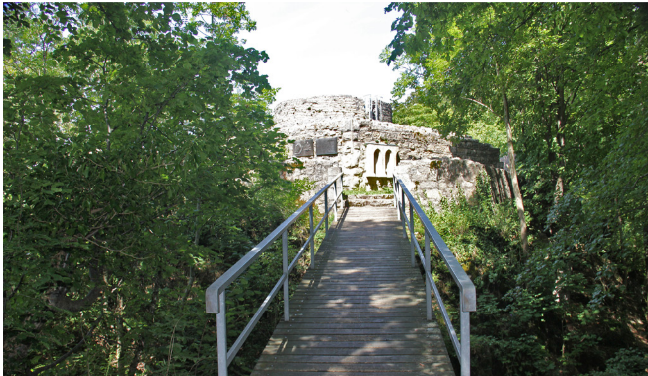
Brücke und Eingang zur Ruine Bischofstein.
