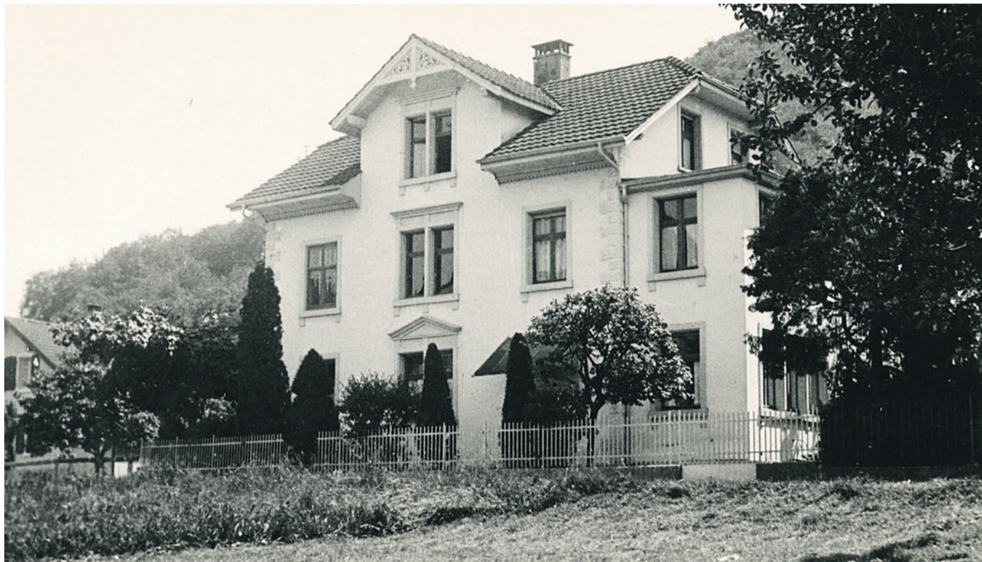
Liegenschaft Oberer-Matter (Nordseite) in der Kreuzmatt um 1935.
